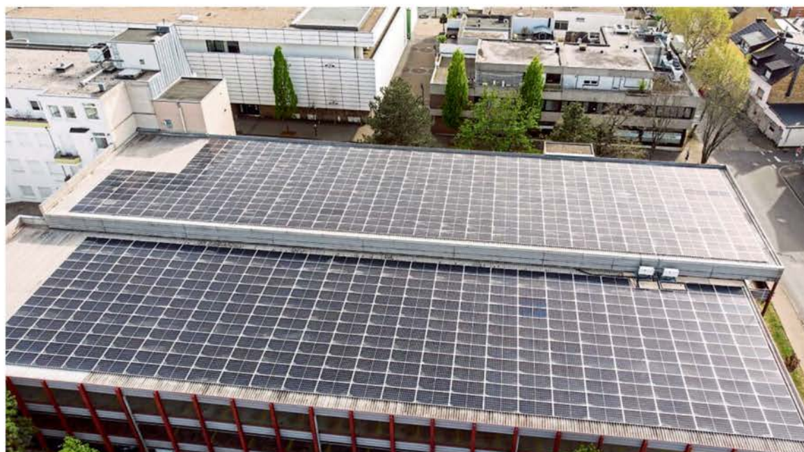
Mehr als zwölf Tonnen wiegt die Solaranlage auf dem Parkhaus an der Euskirchener Spiegelstraße.
